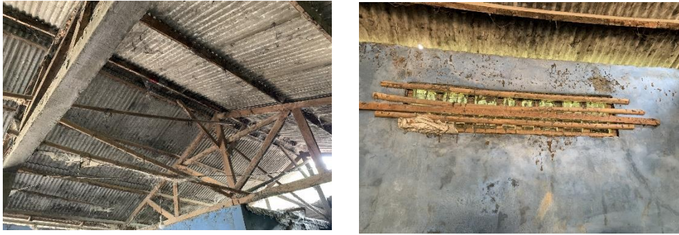
Gambar 3. Kondisi Bangunan (Atap, dinding, ventilasi) Responden
