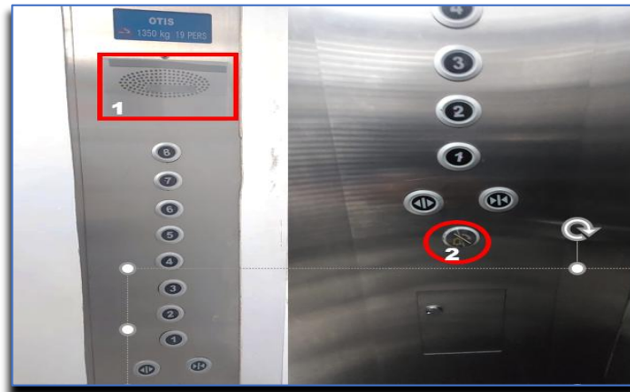
Gab 3 : Lift Microfon (1_ dan tombol pemanggil security (2)
